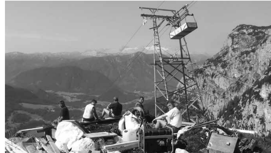
Das Seilbahn-Team bei der Errichtung einer neuen Stütze am Almburg
