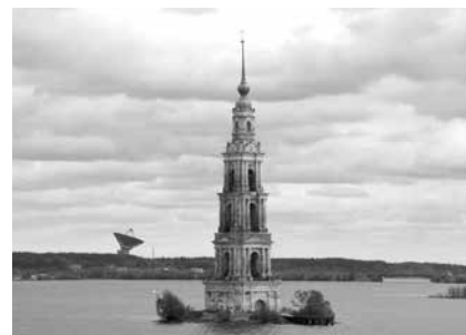
Versunkener Kaljasiner Glockenturm im Uglitscher Stausee
