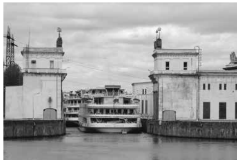
Bei einer der 17 Schleusen angestellt
